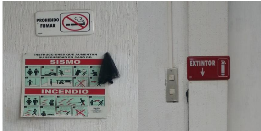
Figura 20. Señalización en paredes
