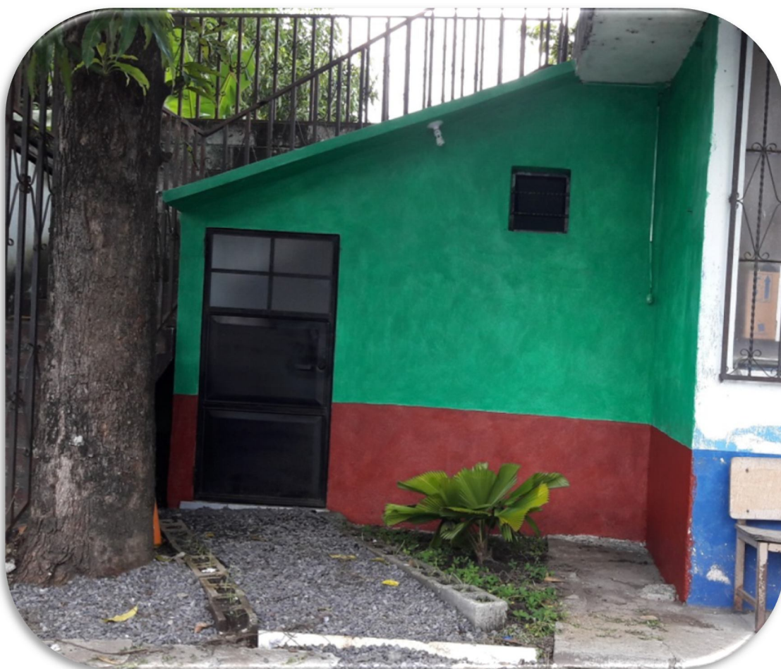
Vista anterior del proyecto terminado
