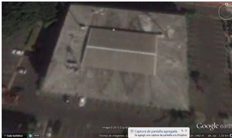
Figura 43. Vista satelital de la terraza del edificio S12
