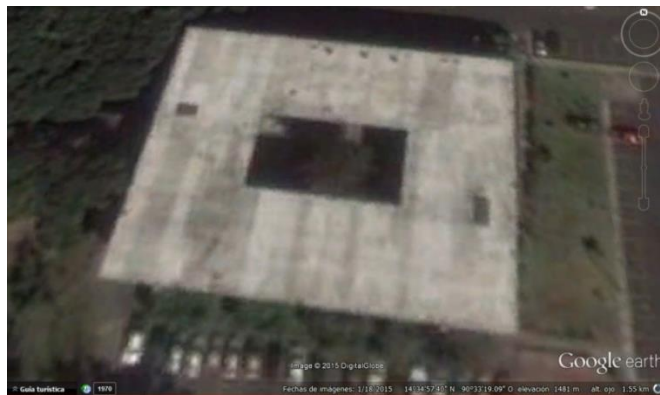
Figura 41. Vista satelital de la terraza del edificio S11
