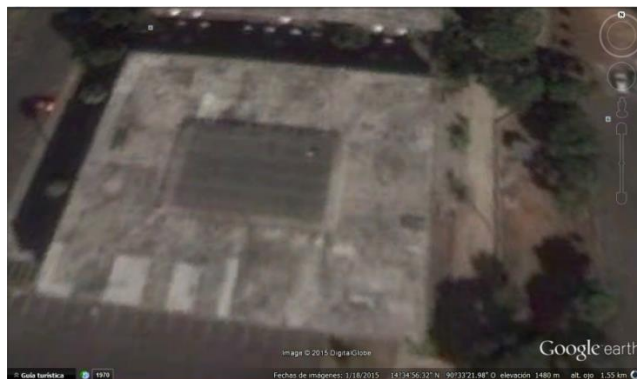
Figura 39. Vista satelital de la terraza del edificio S10
