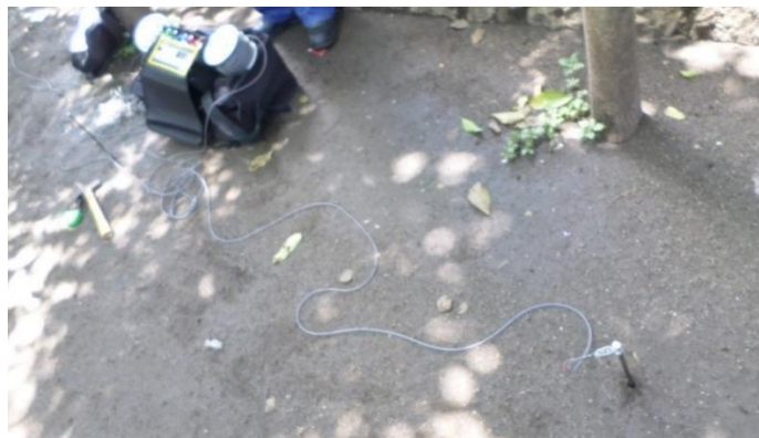
Figura 59. Conexión del megger con los electrodos para realizar la medición
