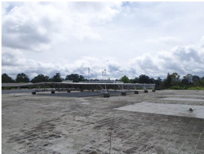
Figura 40. Área disponible en la terraza del edificio S10
