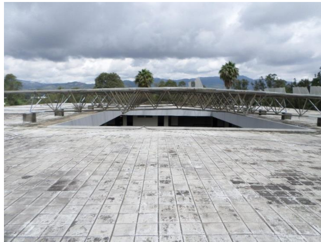
Figura 34. Parte techada del edificio S10
