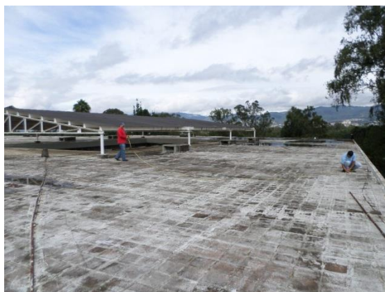
Figura 38. Medición de área disponible en el edificio S9
