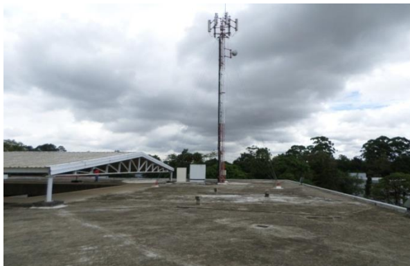
Figura 45. Área disponible en la terraza del edificio S12
