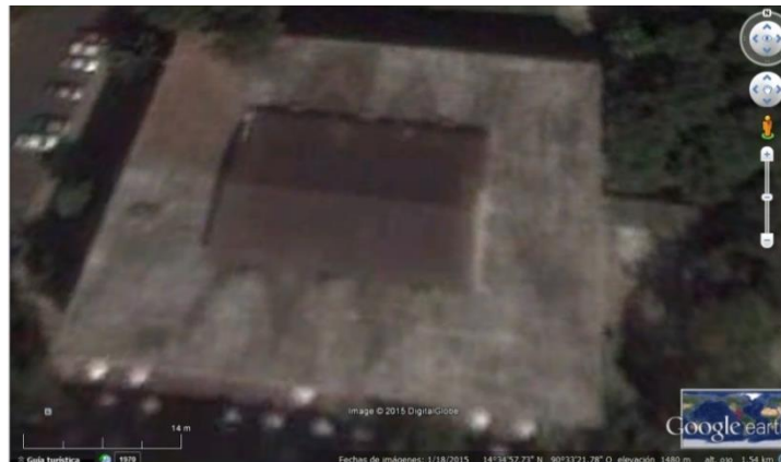
Figura 37. Vista satelital de la terraza del edificio S9
