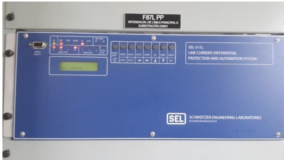
Figura 65. Pruebas a los gabinetes de protección
