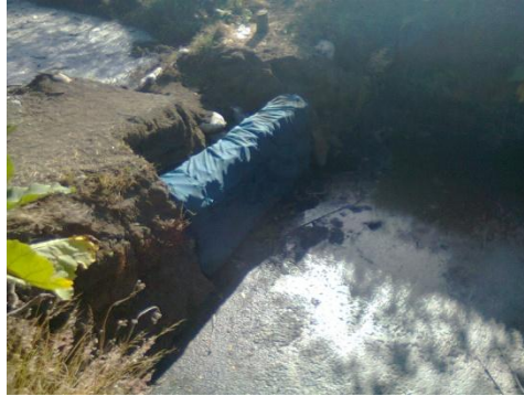
Figura 5. Filtro colocado en las fosas de decantación para la recuperación de sólidos flotantes.
