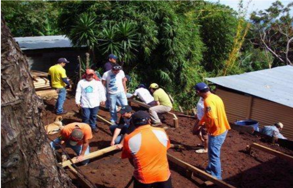
Figura 35. Construcción casas prefabricadas II
