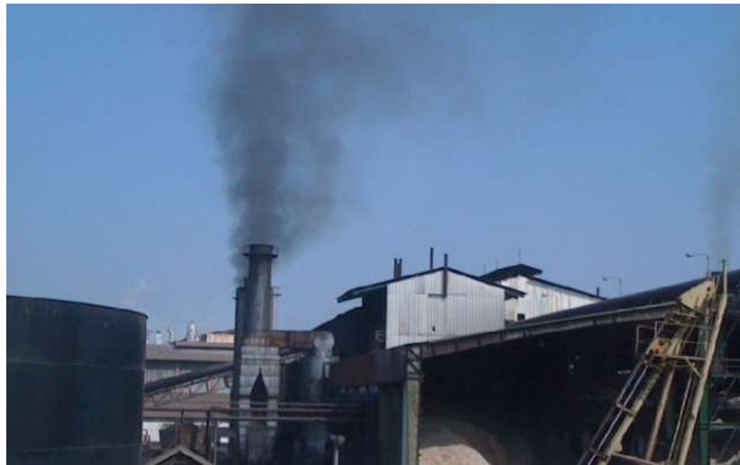
Figura 5. Trampas de humedad apagadas en chimeneas.
