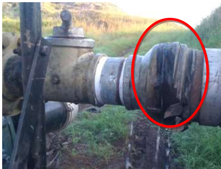
Figura 4. Mantenimiento realizado al sistema hidráulico.
