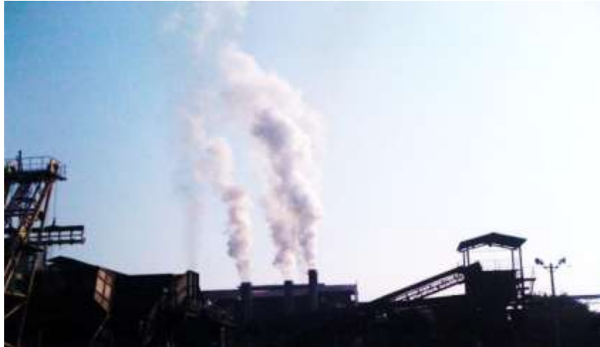
Figura 6. Trampas de humedad encendidas en chimeneas.
