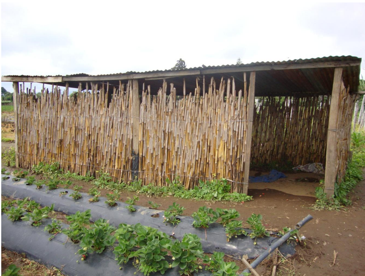
Figura 120. Estructura de caña y lámina en la parcela de producción de fresa.
