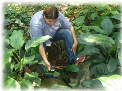
Figura 24. Toma de puntos para la definición de la ruta del paso de la tubería
