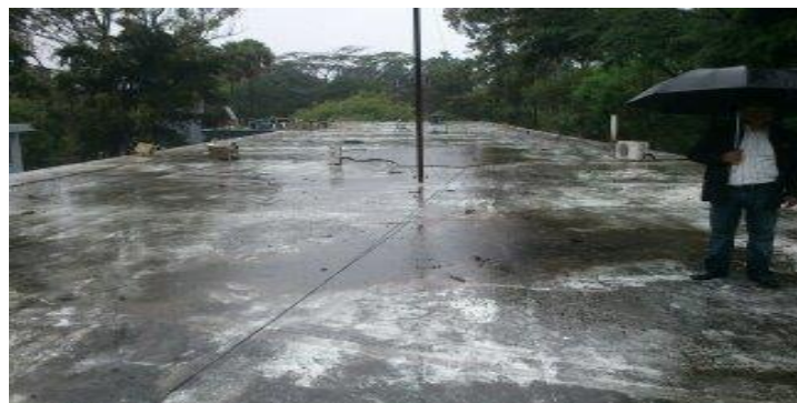
Figura 23. Área disponible en la terraza del edificio T-11
