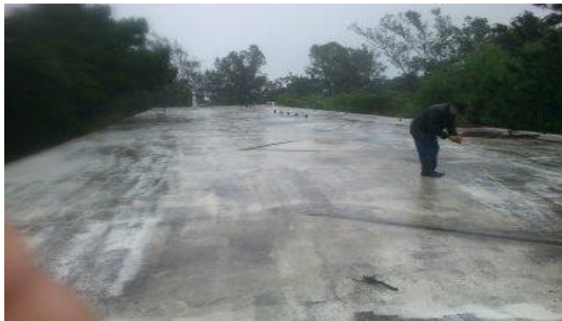
Figura 22. Área disponible en la terraza del edificio T-10
