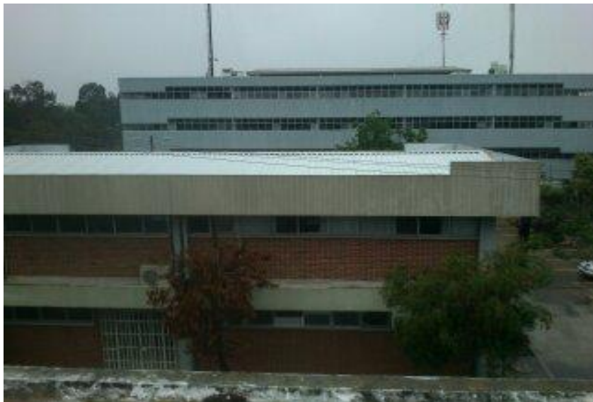
Figura 25. Área disponible en la terraza del edificio T-13
