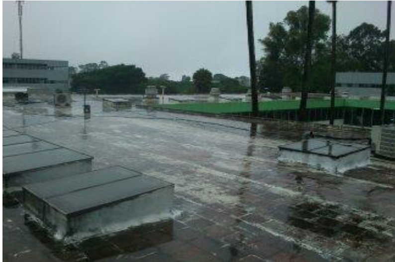
Figura 24. Área disponible en la terraza del edificio T-12
