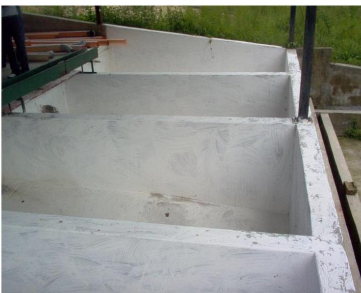
Figura 82. Pilas de fermento del beneficio de café tecnificado
