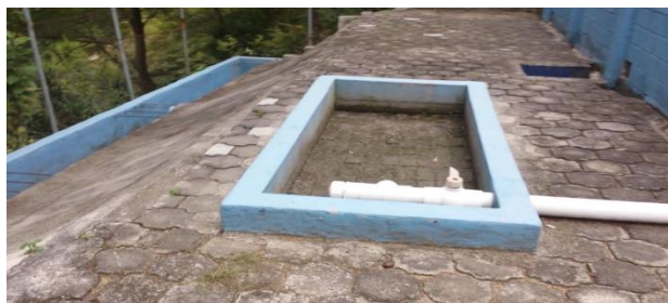
Figura 6. Patio de secado de lodos
