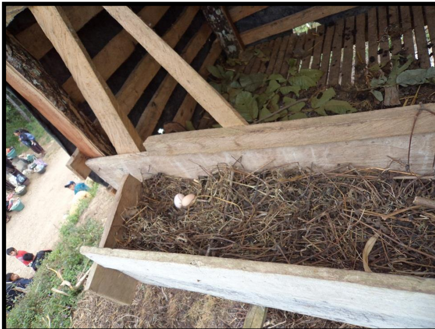
FIGURA NO. 4 APRISCO EN DESUSO
