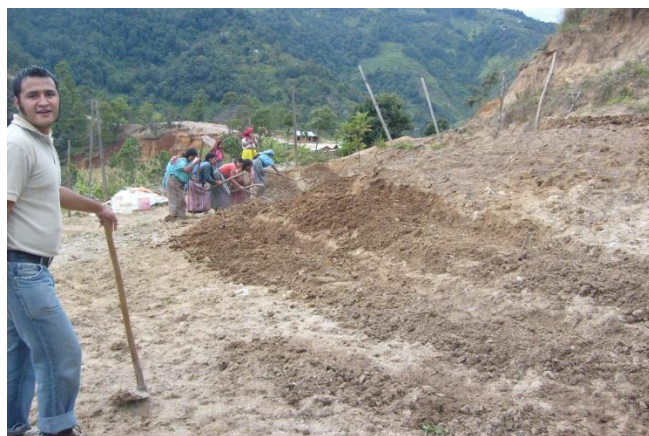
Figura 45. Preparación del terreno para la implementación del vivero comunitario en aldea Nueva Victoria, Sipacapa.
