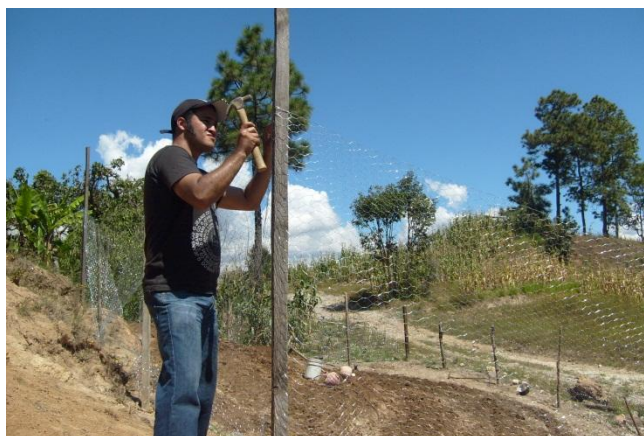
Figura 46. Instalación de malla perimetral en terreno preparado para la implementación del vivero comunitario en Nva. Victoria, Sipacapa.
