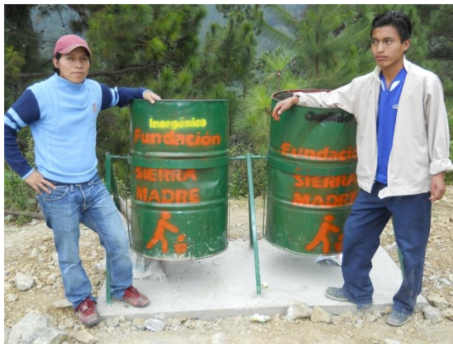
Figura 44. Baterías de clasificación de residuos sólidos instaladas en aldea Baljetre.
