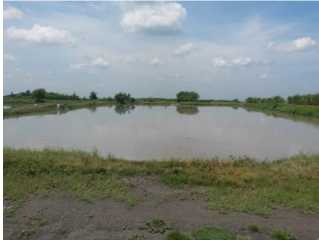
Figura 19. Pileta de decantación de Ingenio Madre Tierra
