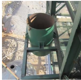
Figura 51. Instalación de tanque para preparación de floculante
