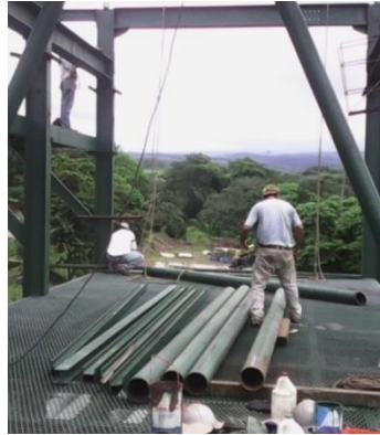
Figura 30. Tubos redondos para arriostamiento de la estructura
