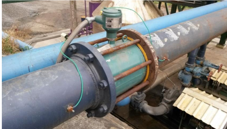
Figura 86. Instalación de transmisor de flujo de agua clarificada
