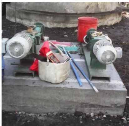
Figura 64. Instalación de bombas de floculante
