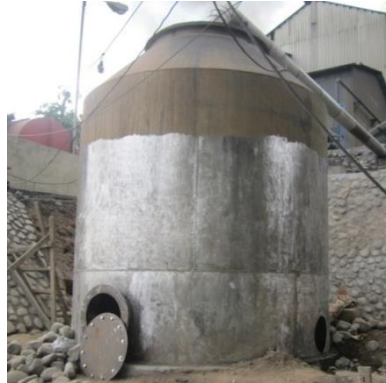
Figura 35. Instalación de tanque para agua con cenizas
