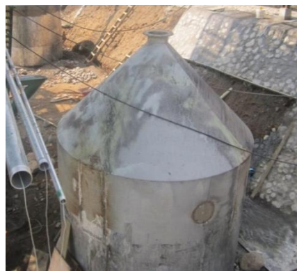
Figura 36. Instalación de tanque para agua limpia
