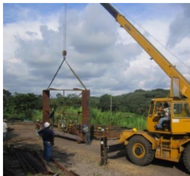
Figura 41. Ensamble de pieza de forma prismática rectangular en la parte superior de las tolvas de decantación
