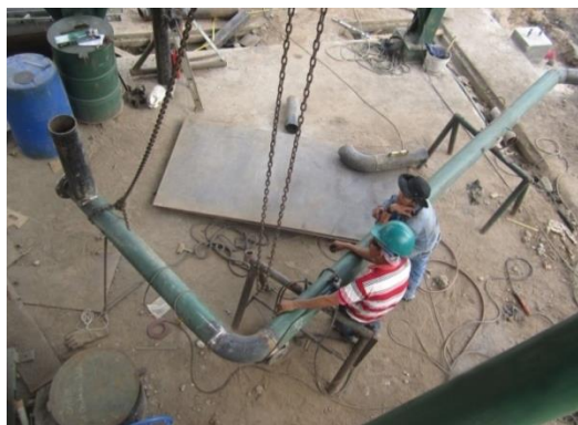
Figura 81. Ensamblaje e instalación de tubería para agua filtrada de la prensa deshidratadora de lodos
