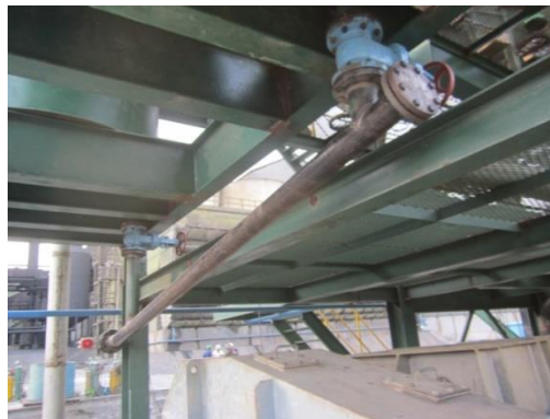
Figura 79. Instalación de tubería de lechada de cal
