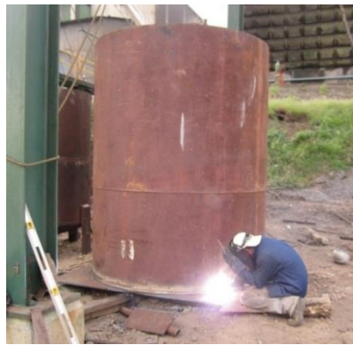
Figura 44. Construcción de tanque para preparación de lechada de cal.
