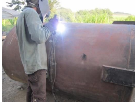
Figura 49. Construcción de tanques para floculante
