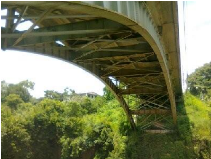
Figura 9. Subestructura del puente existente
