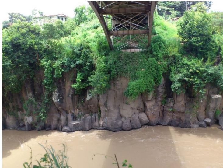
Figura 7. Macizo rocoso en estribo de entrada del puente
