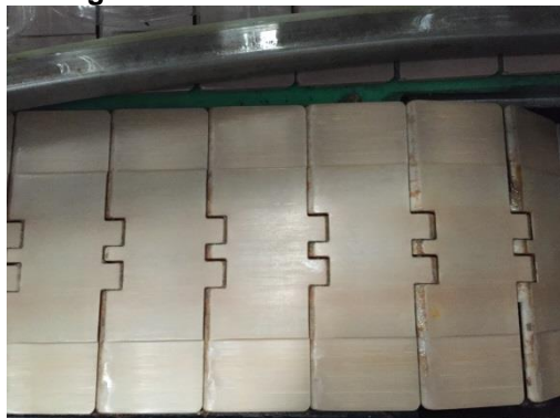
Figura 5. Tablillas en buen estado
