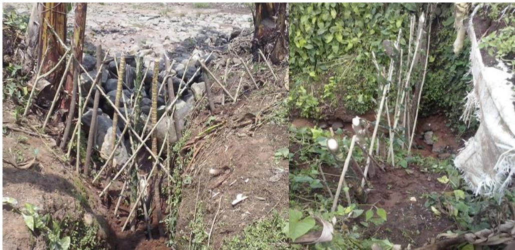
Figura 8: Construcción de barreras vivas.
