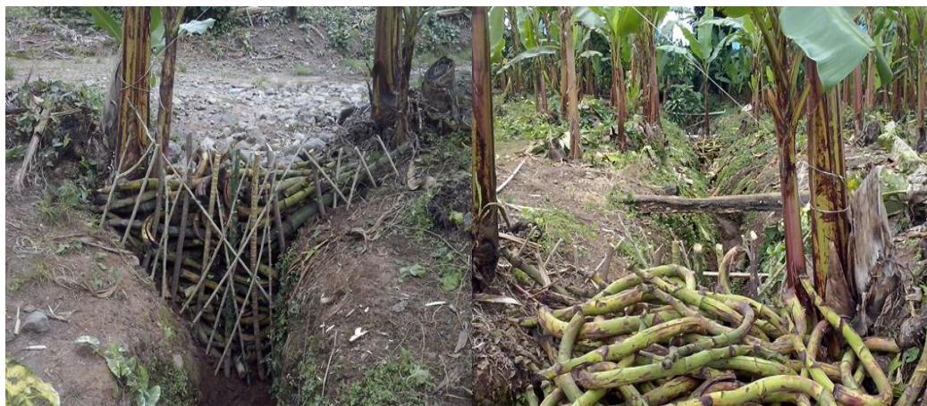
Figura 9: Construcción de barreras vivas en combinación de barreras muertas.
