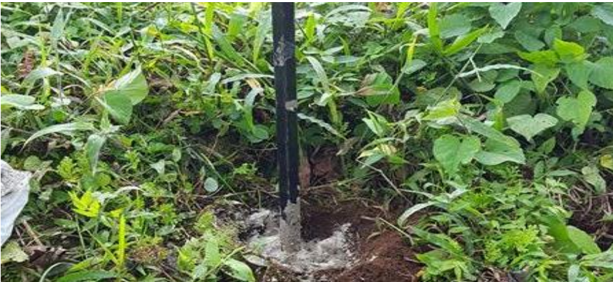
Figura 11: Aplicación de mezcla y colocación de rótulos. Fuente: Autor, 2016.
