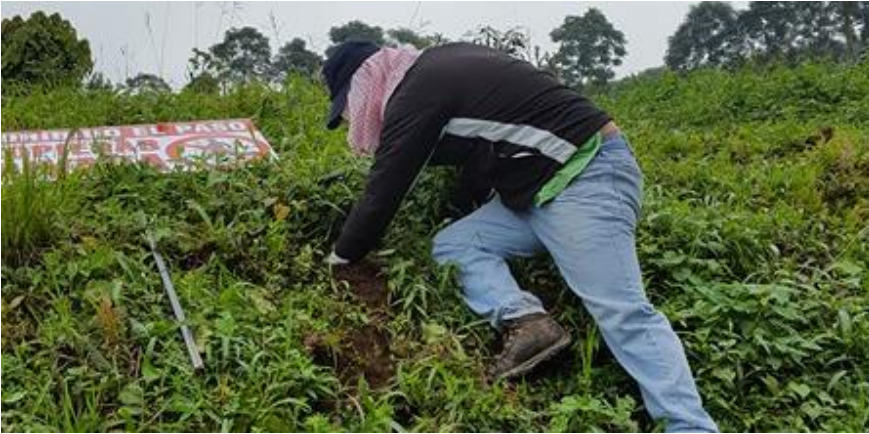
Figura 10: Apertura de agujero para colocación de rótulos Fuente: Autor, 2016.
