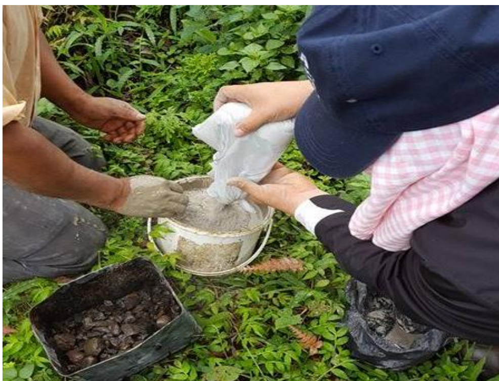
Figura 9: Mezcla de cemento, agua y piedrín para fundir rótulos.
