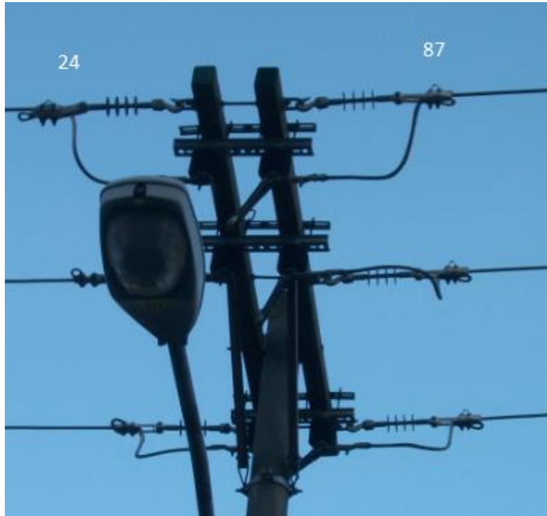
Figura 28. Remate de circuitos en poste 156057
