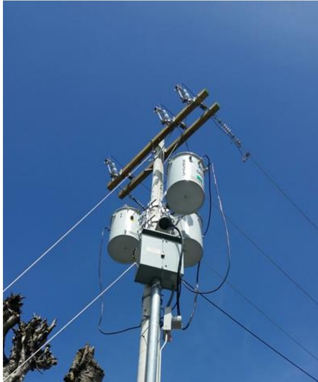
Figura 23. Medición secundaria en poste
