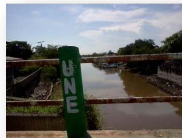
FOTO 45: Puente sobre Canal Chiqimulilla.
