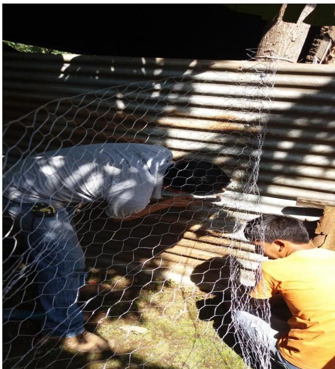
**Figura 16: Colocación de malla.**
