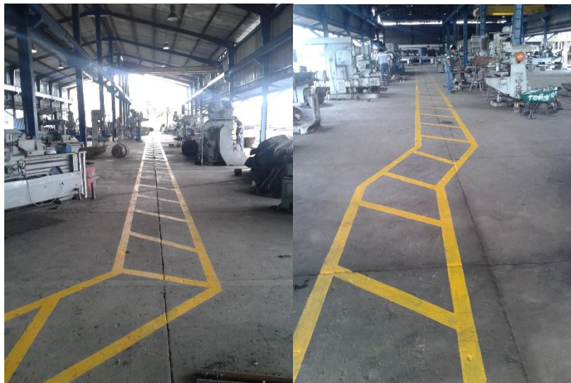
Figura 8. Elaboración de caminamientos para pasillos internos
