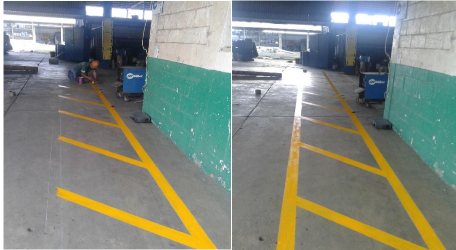
Figura 7. Elaboración de caminamientos para entrada principal
