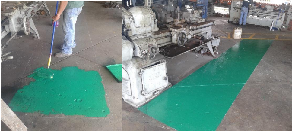
Figura 9. Aplicación de verde para área operativa
