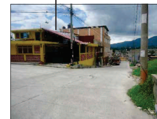
FOTOGRAFÍA COLINDANCIA 4TA AVENIDA ZONA 4 DE SAN PEDRO SAC. TIPO DE PAVIMENTO: CONCRETO ARMADO DOS BLOQUES DE 3.35 MTS. POR CARRIL. DOBLE VÍA
