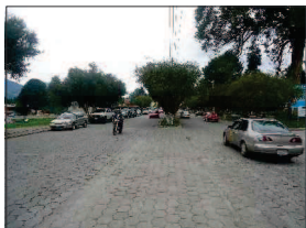
FOTOGRAFÍA CALZADA REVOLUCIÓN DEL 71 GABARITO 1 TIPO DE PAVIMENTO. ADOQUÍN ANCHO DE CALLE 7.30 MTS. ANCHO DE CARRIL 3.25 DOBLE VÍA
