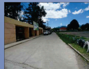
FOTOGRAFÍA CALLE SECUNDARIA COLINDANTE COLEGIO TECNOAMERICANO E IGLESIA EL CANDELERO TIPO DE PAVIMENTO: CONCRETO ARMADO ANCHO 6.20 2 BLOQUES DE 3.10 MTS DE ANCHO POR CARRIL. UNA VÍA
