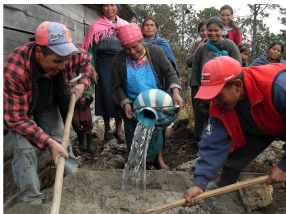
Figura 14 Construcción de las bases para la colocación de los depósitos de agua
