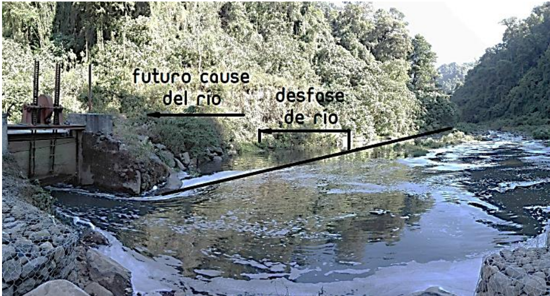
Figura 8. Desfase de la trayectoria del río Samalá en la entrada al embalse
