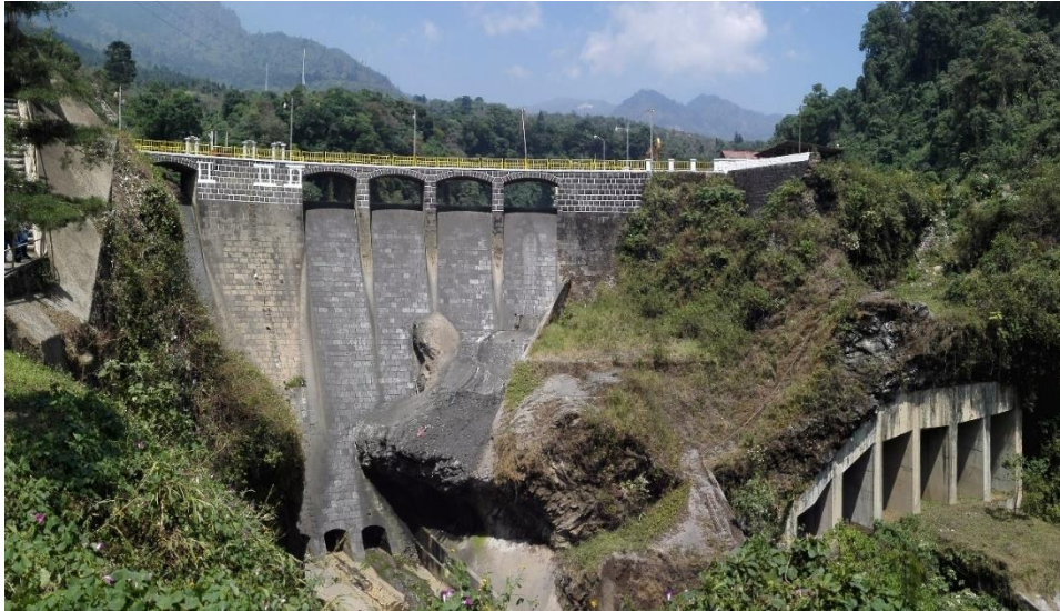
Figura 1. Fotografía de la presa vista aguas abajo
