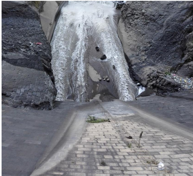
Figura 2. Vista del canal de desfogue desde la corona de la presa
