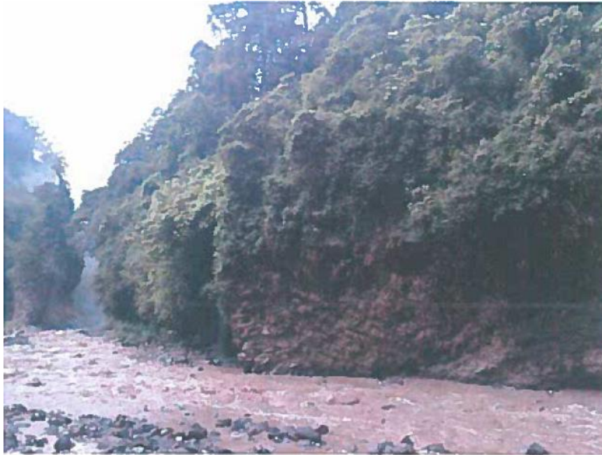
Figura 14. Lavas andésticas margen derecha, aguas abajo con base del vertedero
