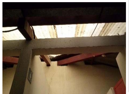
Imagen 4: Estructura del inmueble.
