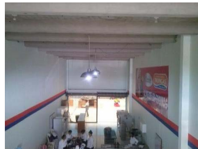
Imagen 4: Vigas de concreto en talleres.
