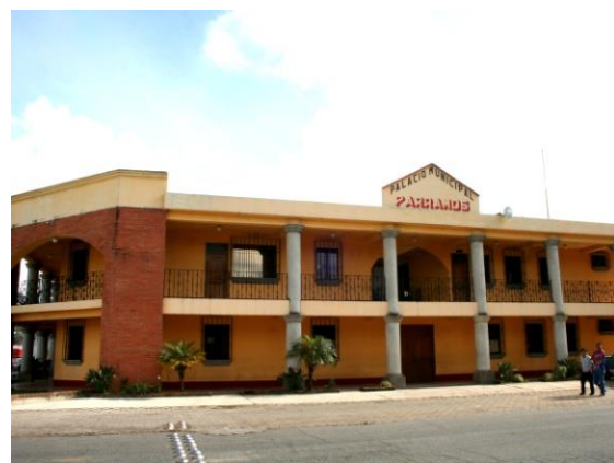
Palacio Municipal, Parramos, Chimaltenango Fuente: foto propia
