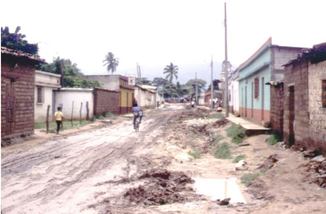
IMAGEN 9: Inicios del Municipio de Nueva Santa Rosa.
