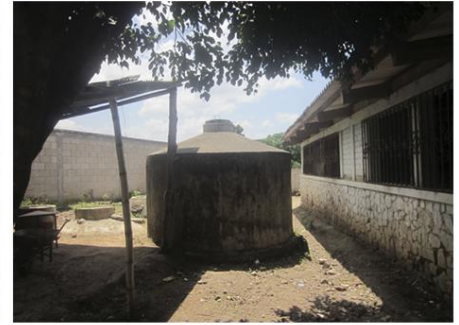
3. ANTIGUOS TANQUES DE COMPOST
