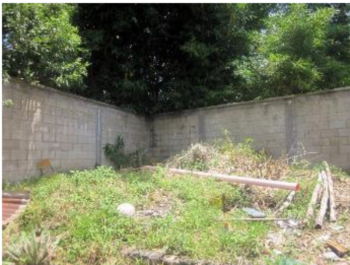
AREA EXTERIOR NOROESTE
