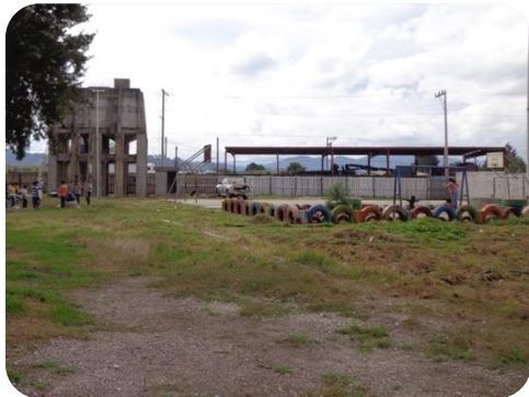
Dentro del terreno existe una cancha polideportiva en estado de deterioro que es usada por estudiantes de la escuela IMAGEN NO. 10 - Foto propia
