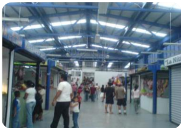
Cubierta de lámina translúcida en áreas donde el ordenamiento de locales es lineal IMAGEN NO. 26 Foto: Propia
