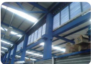
Estructura metálica combinada con estructura de concreto reforzado IMAGEN NO. 27 Foto: Propia
