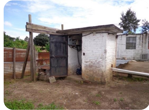
A un costado de la bodega se ubica el pozo de agua y su cuarto de máquinas, que es utilizado para distribuirla a los cantones cercanos. IMAGEN NO. 12 - Foto propia
