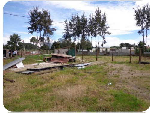
Materiales para la construcción se encuentran dispersos en el terreno, provocando contaminación visual. IMAGEN NO. 16 - Foto propia
