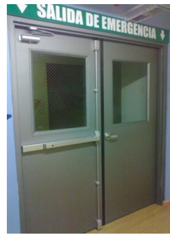
SALIDA DE EMERGENCIA DEBIDAMENTE IDENTIFICADA
