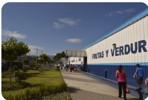
Se observan anchos adecuados de pasillos para la circulación Imagen NO. 20 Foto: propia
