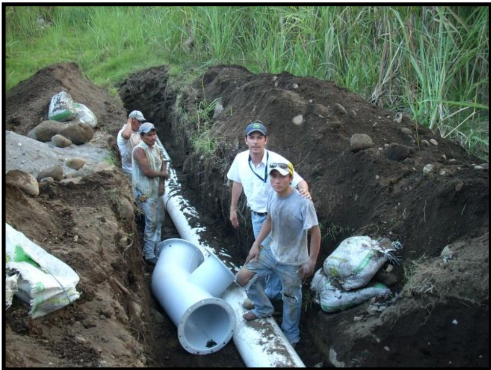
Figura 26: Instalando el tubo de PVC y accesorios del sistema
