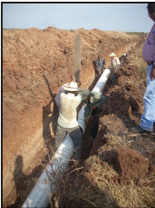
Figura 10: Instalación de la tubería de pvc, en finca San Nicolás
