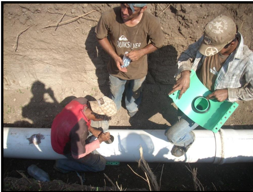
Figura 12: Perforación del agujero para la montura del hidrante
