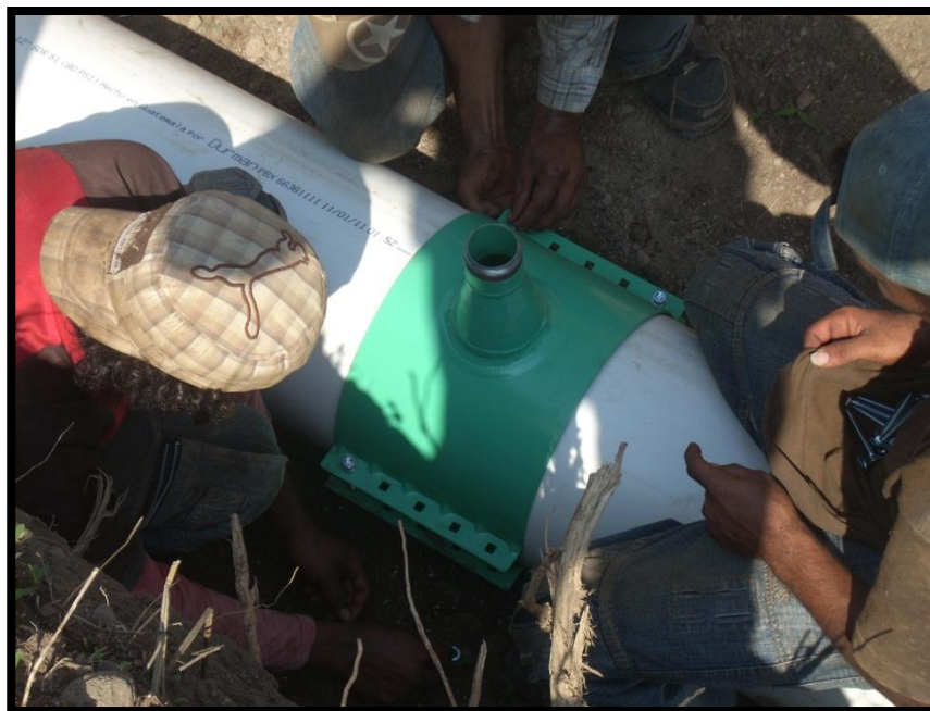
Figura 13: Instalación de una montura para la colocación del hidrante de riego
