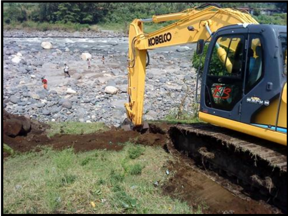
Figura 25: Elaboración del canal de llamada en el río Madre vieja
