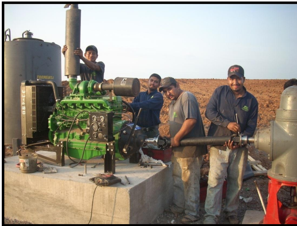
Figura 14: Instalación del equipo de bombeo de un pozo a cargo de Magrisa.
