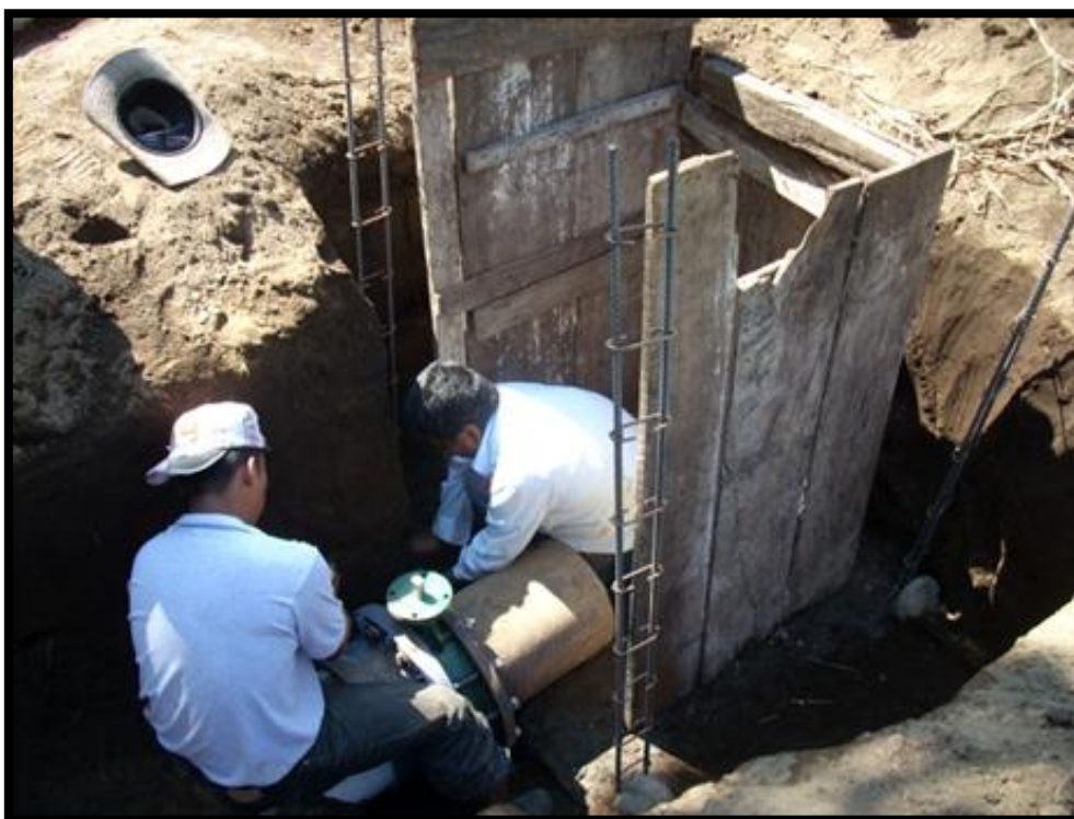
Figura 28: Construcción de una caja dispersora con la válvula de Grinell instalada.
