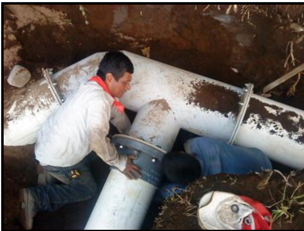
Figura 27: Instalando una tee de metal tipo dresser, para distribuir el agua en la caja dispersora.
