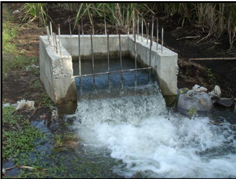
Figura 30: Caja de dispersión aplicando agua a los surcos
