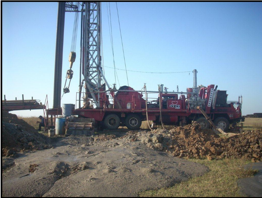
Figura 6: Empresa DAHO perforando un pozo
