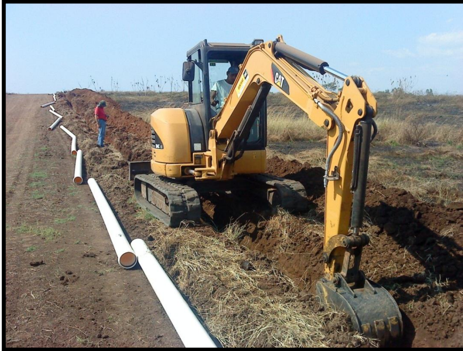
Figura 9: Procedimiento de la excavación de la zanja para la tubería de pvc
