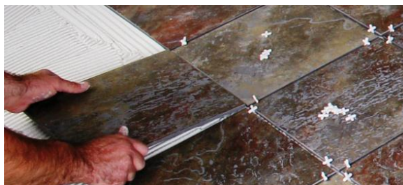
Figura 2. Colocación de piso cerámico
