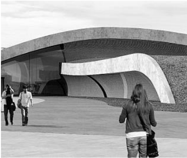
FOTOGRAFÍA # 12 Cubierta curvas FUENTE: http://decorar.org/wp-content/uploads/2009/04/cubierta-para-piscina-domo-3.jpg , del año 2004
