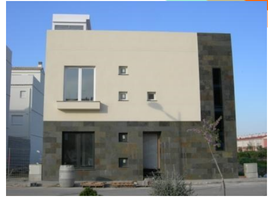
FOTOGRAFÍA # 13 Fachada Frontal FUENTE: http://www.infojardin.com/galeria/showphoto.php?foto=42699&size=big&cat= , del año 2,007
