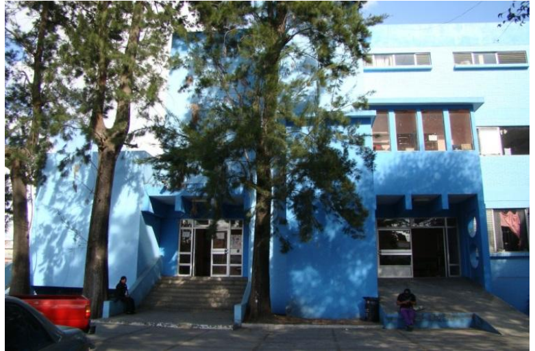
IMAGEN No 6.6 Fuente propia. Áreas del Hospital San Juan de Dios Ingreso a emergencia maternidad
