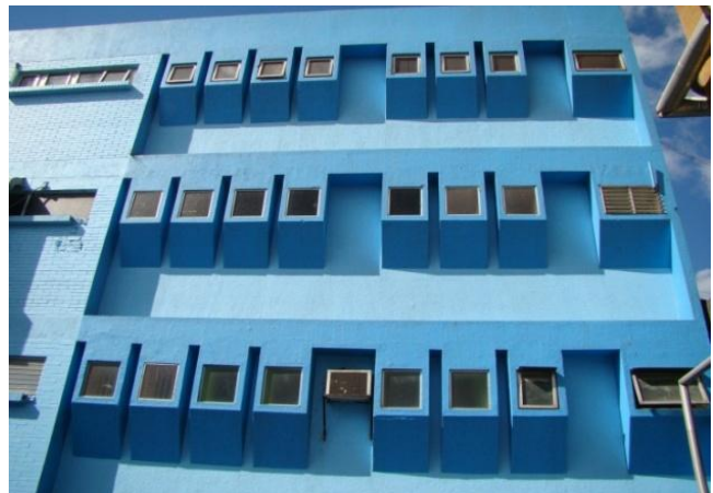
IMAGEN No. 6.12Fuente HGSJDIimagen de estructura, ventanería
