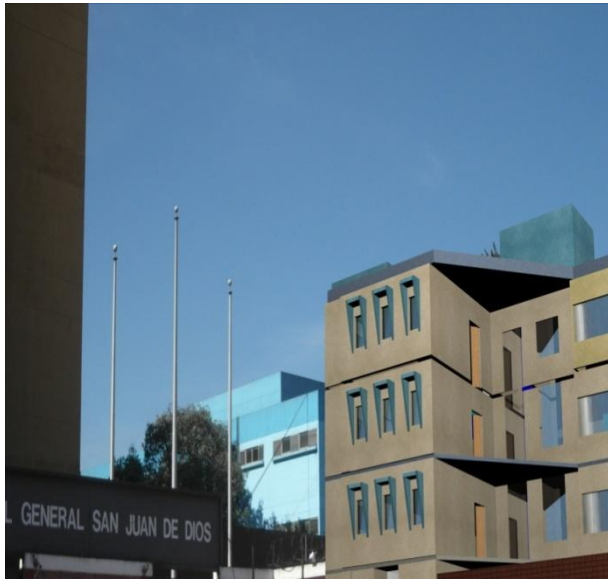
VISTA HACIA EL ESTE, INTEGRACIÓN AL ENTORNO
