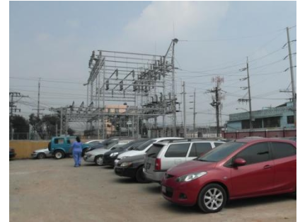
IMAGEN 2 Vista hacia las torres eléctricas
