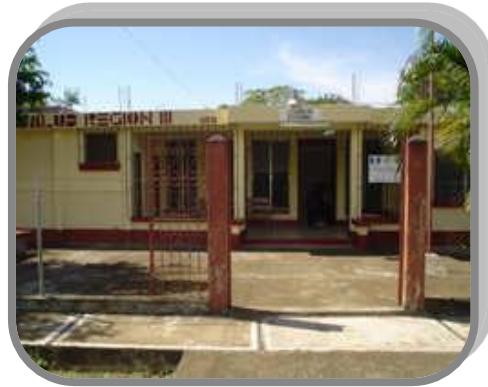
IMÁGEN DEL PROYECTO No8" Parte frontal del Centro del Salud de El Estor. Este centro atiende predominantemente a poblaciones de origen Maya. Se encuentra ubicado en una de las zonas más remotas del país. (FHI)
