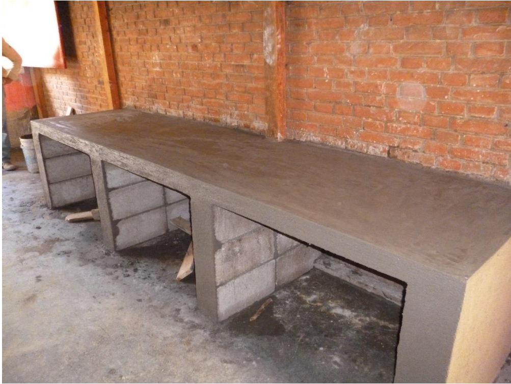
Imagen 11. Mesa de cemento y ladrillos que se colocó.
