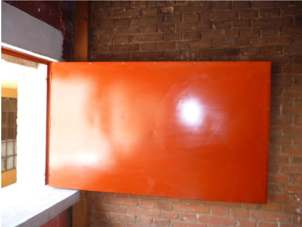
Imagen 8. Las ventanas metálicas ya cementadas en los orificios, así como también la mocheta.
