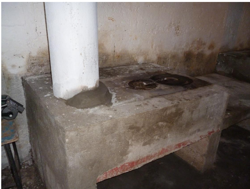
Imagen 5. Poyos completamente restaurados y plancha metálica nueva y correctamente colocada.
