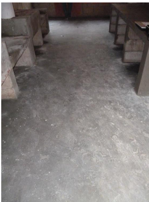
Imagen 10. Plancha de cemento pulido que se colocó.
