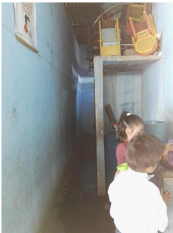
Fotografía No. 3. Estado inicial del pasillo
