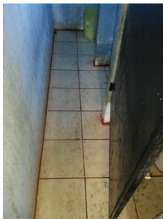
Fotografía No. 9. Colocación de piso cerámico
