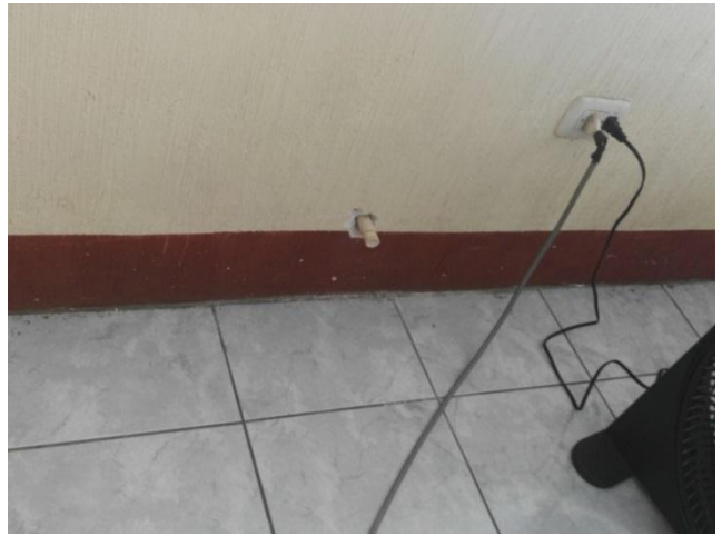
Fotografía No. 20. Colocación de tubería
