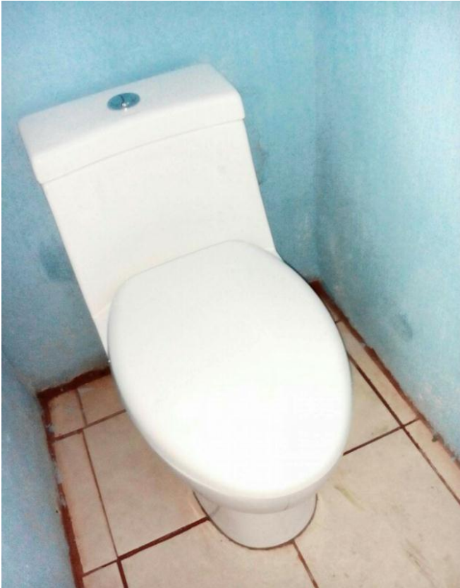
Fotografía No. 11. Inodoro terminado
