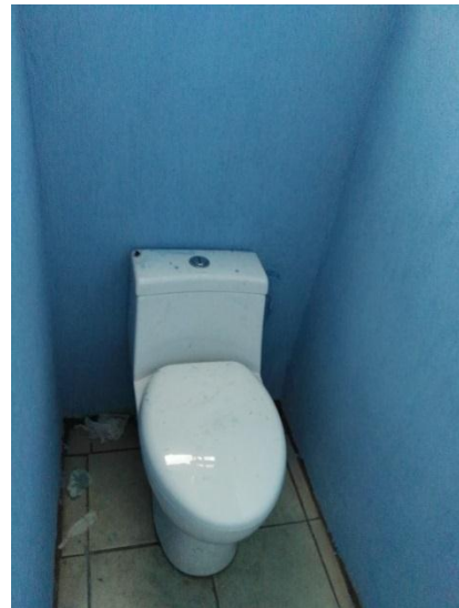
Fotografía No. 8. Cambio de inodoro
