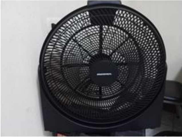
Fotografía No. 15. Colocación de ventiladores
