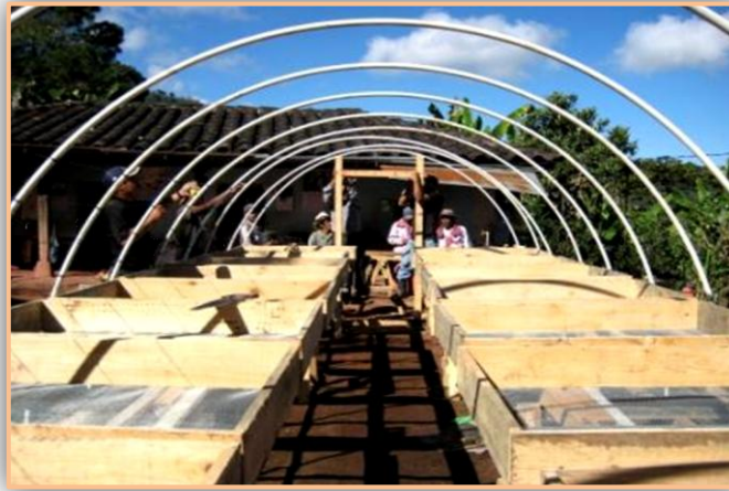
Figura 5 Construcción de secadora solar tipo domo
