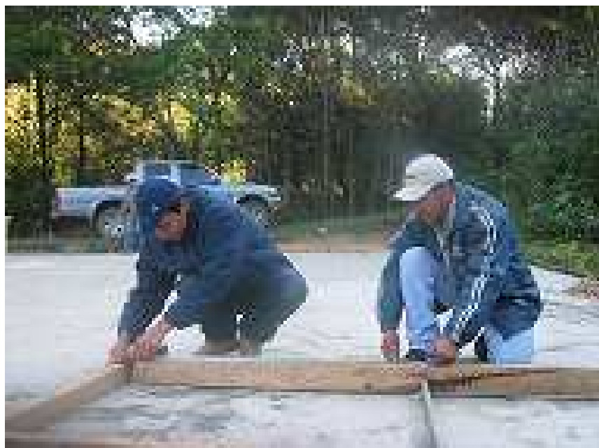
Figura 23: Delimitación de área de bandejas en patio de concreto.
