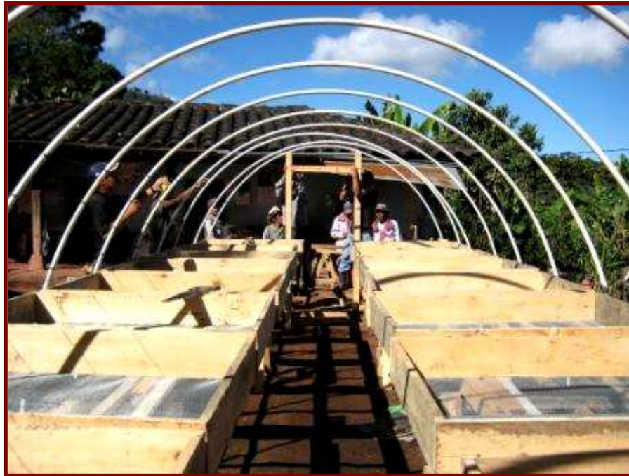
Figura 8: Construcción de secadora solar tipo domo
