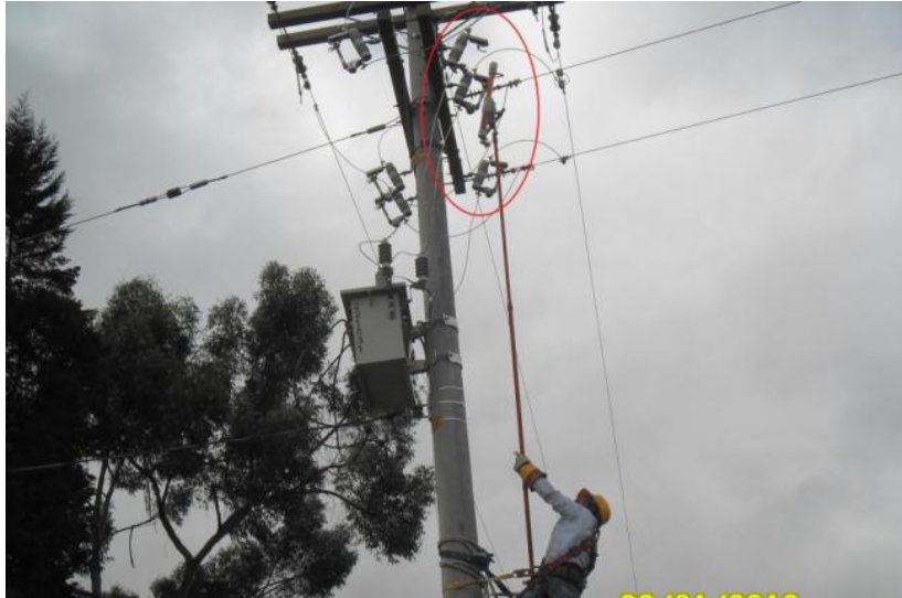
Figura 2. Corte de fuente de tensión
