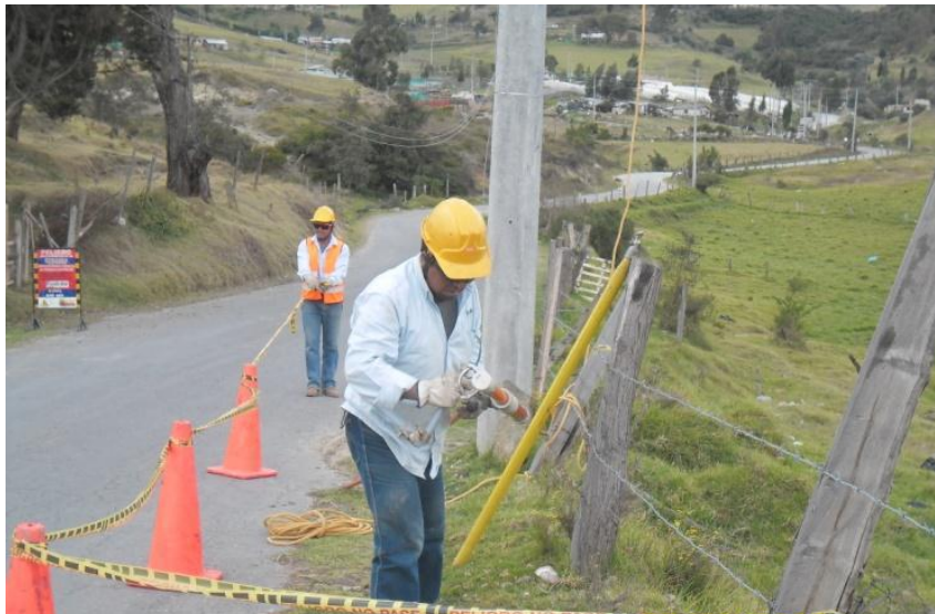
Figura 3. Señalización de trabajo
