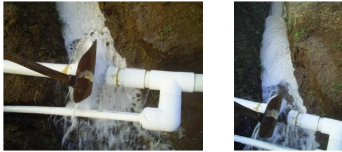
Figura 74 y 75. Limpieza y desinfección de tubería principal
