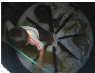
Figura 72 y 73. Limpieza y desinfección de tanques de agua
