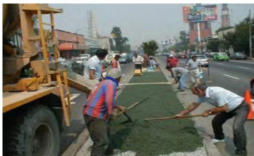
Figura 13. Colocación de concreto permeable
