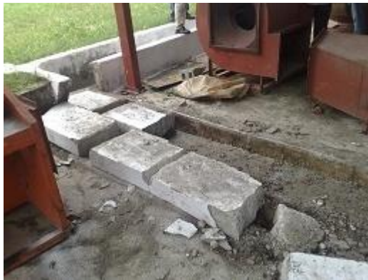
Figura 10. Arreglos del beneficio para la instalación de nuevas maquinas.
