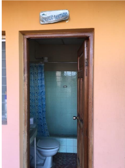
Figura 10. Instalación de servicio sanitario
