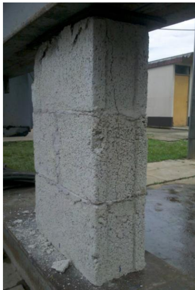
Figura 4. Falla típica de separación, ensayo a compresión prismas
