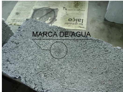
Figura 22. Reverso de placa de mortero
