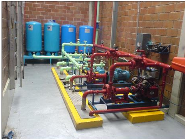
Figura 9. Depósito de agua
