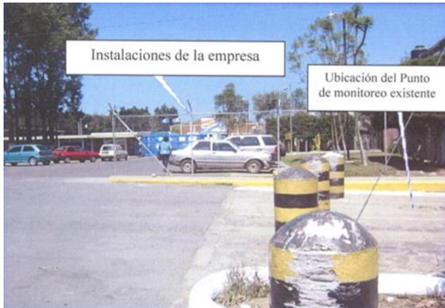
Fuente: Planta panificadora.
