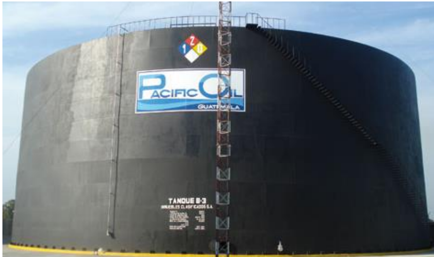
Figura 2. Tanque de combustible bunker c
