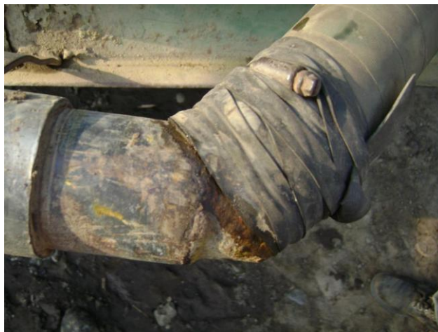
Figura 5: Manguera de la bomba de agitación.
