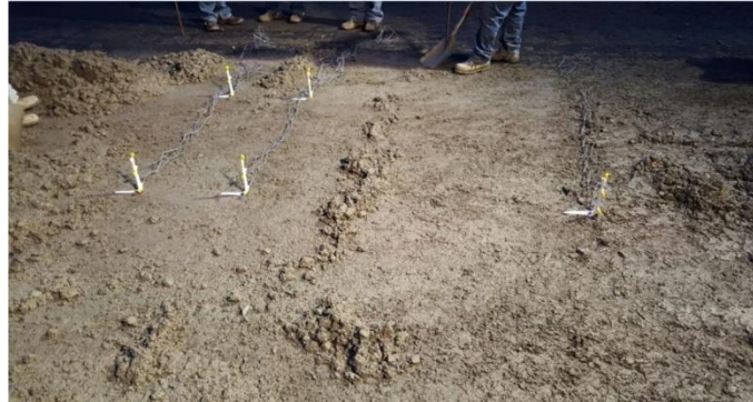
Figura 66. Colocación de los sensores en la losa
