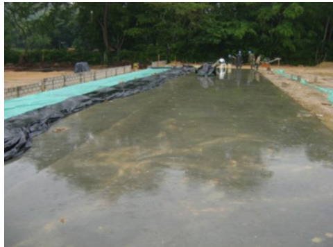
Figura 50. Curado con agua
