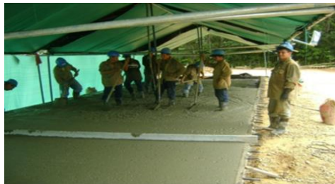
Figura 55. Curado mediante toldos
