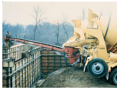
Figura 42. Banda transportadora montada sobre camión mezclador
