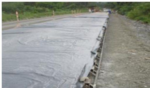
Figura 52. Curado con cubiertas que retienen la humedad
